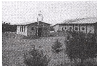
IGREJA EM CONSTRUÇÃO NA LINHA KM 15 MAR... ~307 KB
